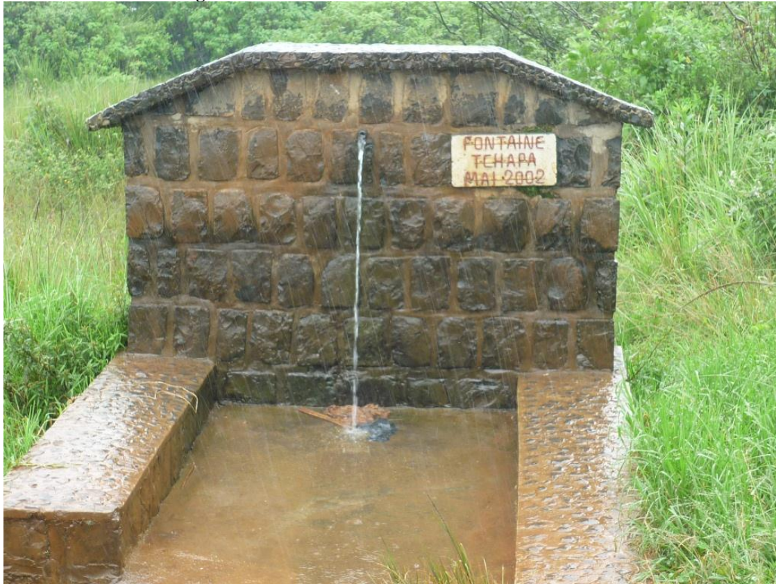
Figure 9 - Fontaine entre le Tunnel Bana et le Viaduc
